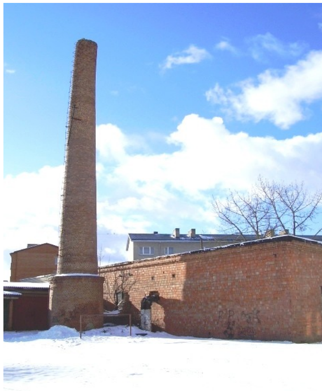
Vana katlamaja mis toimib soojusvõrgu jaotuspunktina
