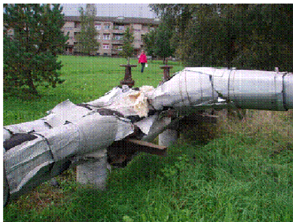
Joonis 2.1 Ligi 50 a vanune maapealne soojusvõrk väikeasulas
