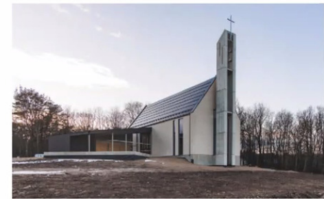
Joonis 11. Näiteid päikesepaneelide kasutamisest katusekattematerjalina (Suure-Jaanis ning Sakus asuv kirik). Allikas: Solarstone
