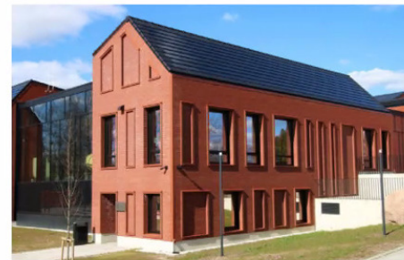
Joonis 11. Näiteid päikesepaneelide kasutamisest katusekattematerjalina (Suure-Jaanis ning Sakus asuv kirik). Allikas: Solarstone
