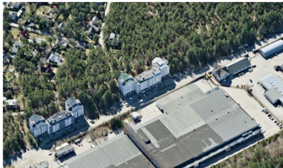
Näide KÜ koostööst: Kalda 64, Tallinnas (vasakul) varustab soojusega ka Kalda 60 kortermaja (paremal) Foto: Maa-ameti Fotoladu
