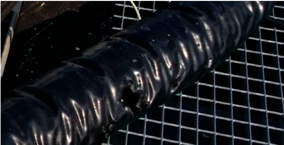
Joonis 4. Linnude poolt kahjustatud soojuskandja toru isolatsioon Figure 4. The insulation of the heat carrier pipe has been damaged by birds
