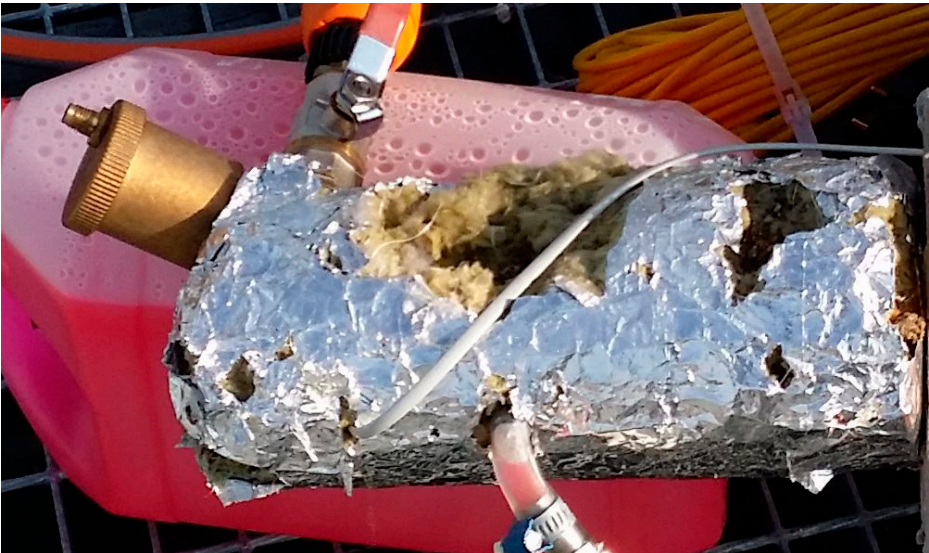
Joonis 6. Lindude poolt tekitatud kahjustus fooliumkattetele Figure 6. Damage of the aluminium foil caused by birds
