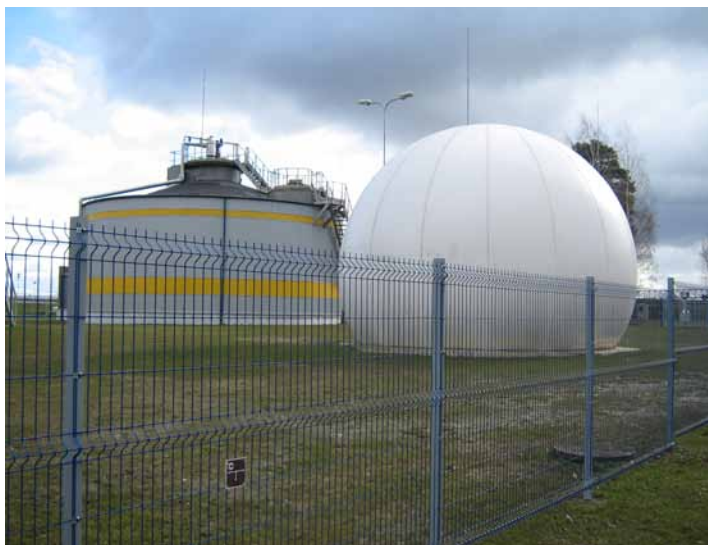
Pilt 1. Digester ja gaasihoidla Panevezise veepuhastusjaamas Picture 1. Digester and gas holder in Panevezis WWTP
