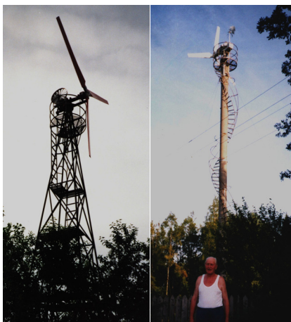
Joonis 2. Meinhard Kivikink valmistas ise 8 kW tuuliku Rakveres oma kodus (vasakul) ja Uno Illipe tegi sama Lüganusel (paremal)
