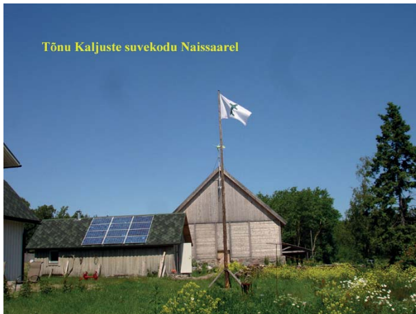
Foto 4. T. Kaljuste suvekodu Naissaarel. Photo 4. PV-installation on Naissaare Island.
