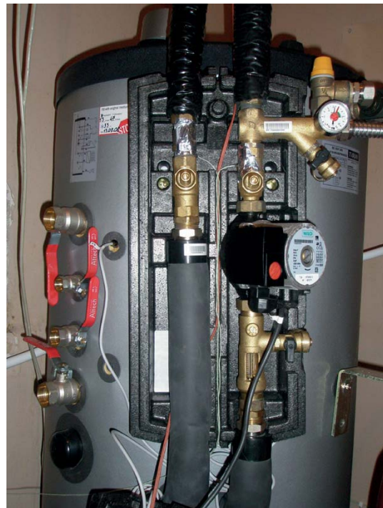
Joonis 3. Vasakul on kahe torusoojusvahetiga 200 dm 3 soojustatud soojaveepaak BE-SSP: paagi esipinnal on näha solaarjaam SD25-RD koos kontrollieriga N-DUPLEX, millest vasakul asuvad tema paagis olevate andurite asetuskohad. Paremal on solaarjaama esipaneeli all asuvad täiturseadmed koos pumbaga Wiko Star ST20/6.
