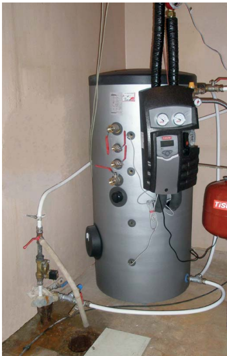
Joonis 3. Vasakul on kahe torusoojusvahetiga 200 dm 3 soojustatud soojaveepaak BE-SSP: paagi esipinnal on näha solaarjaam SD25-RD koos kontrollieriga N-DUPLEX, millest vasakul asuvad tema paagis olevate andurite asetuskohad. Paremal on solaarjaama esipaneeli all asuvad täiturseadmed koos pumbaga Wiko Star ST20/6.
