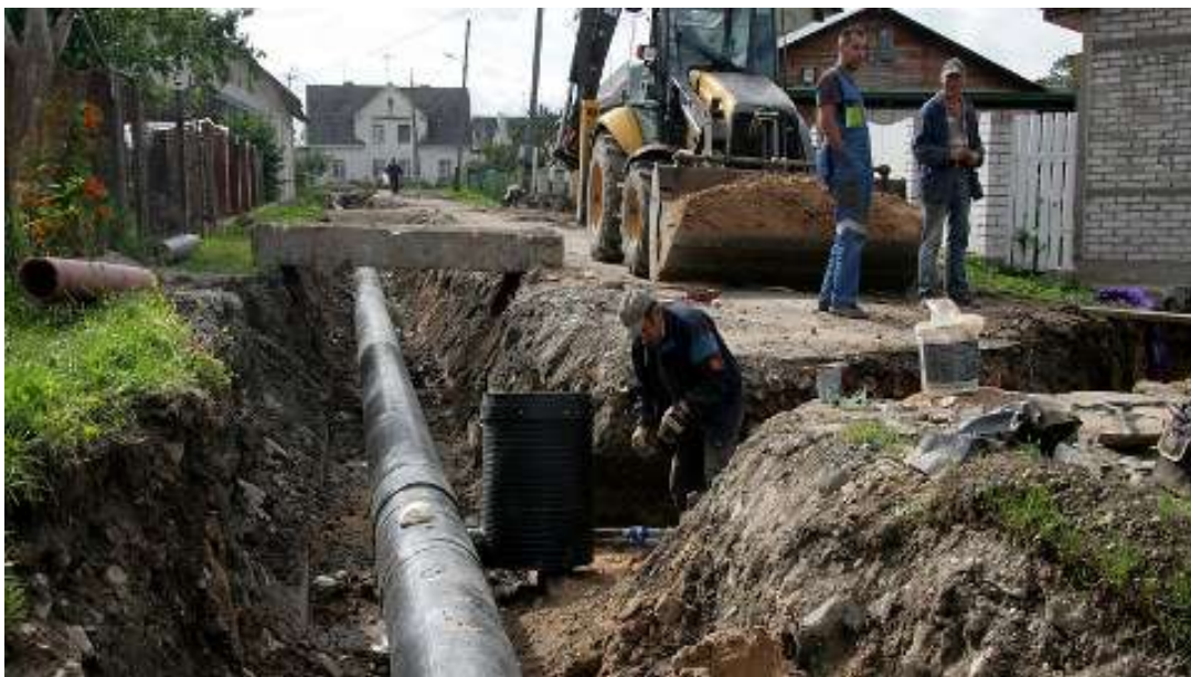
Foto: Sompaa soojustrassi paigaldamine 2012, pr.pohjarannik.ee
