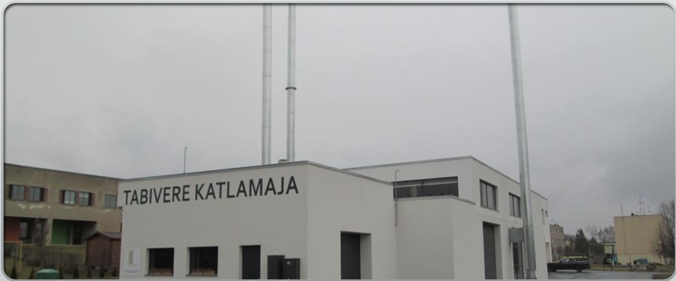
Rekonstrueeritud Tabivere katlamaja
