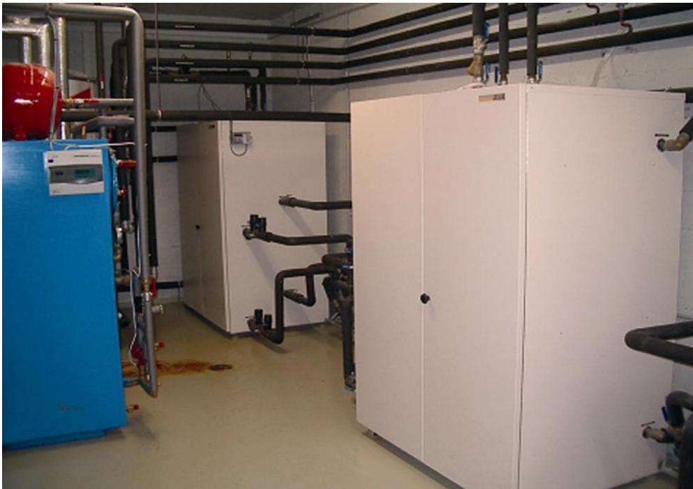
Joonis 6. Soojuspumbad Rõuge Põhikoolis Figure 6. Heat pumps in Rõuge basic school
