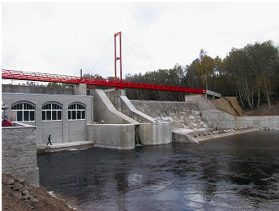
Figure 5. Rehabilitated plant seen from downstream Joonis 5. Vaade taastatud jõuamale
