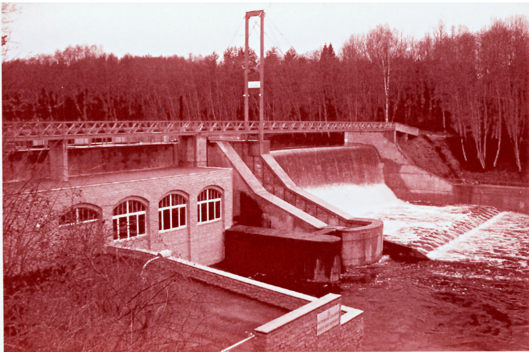
Taastatud Linnamäe hüdroelektrijaam
